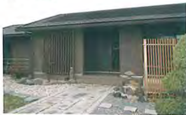
玄関周り。右側に車椅子用のスロープがあります。
